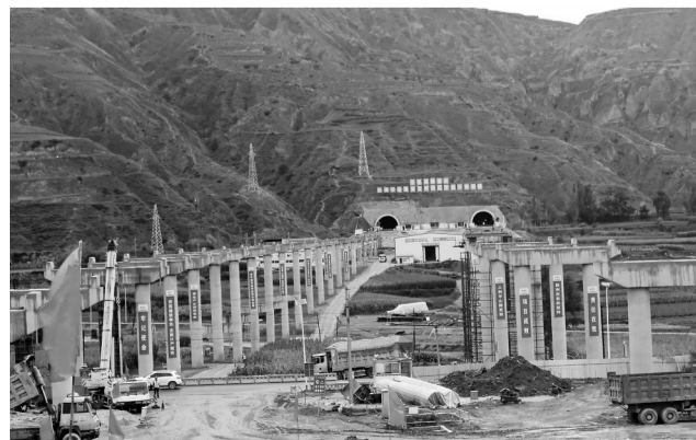
在建的陇漳高速公路
