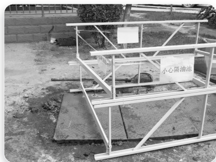
▲用栏杆围起来的“隔油池”。
