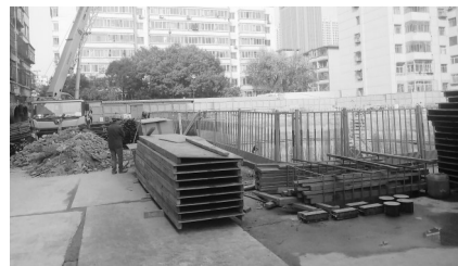
省妇幼保健院家属院内的建筑工地。
