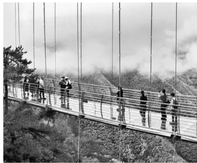
鹅嫚沟景区里的高空玻璃吊桥。
